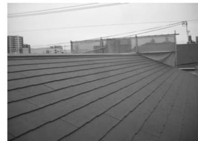
老朽化して棟が波打っていたので、下地を補修して葺きなおしました
